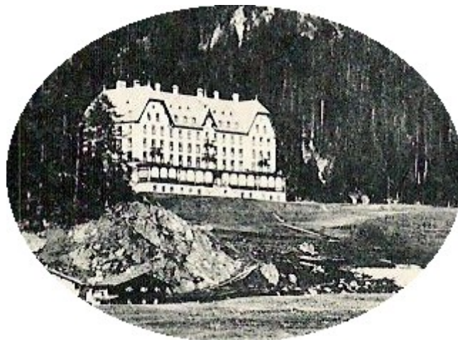
Gründungsbau des Basler Sanatorium (zwischen 1896 und 1900)
